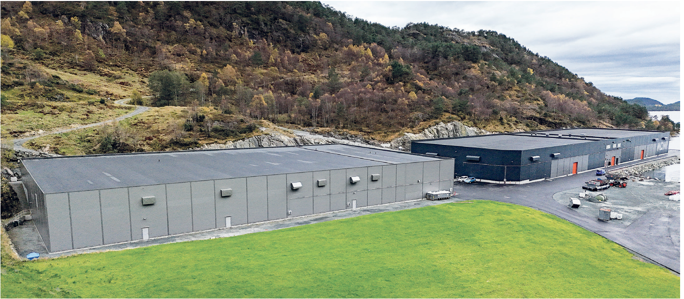
Anlegget til venstre stod ferdig i 2022, anlegget til høyre ble satt i produksjon i år. Til sammen har byggene et bruttoareal på 17500 kvadratmeter.
