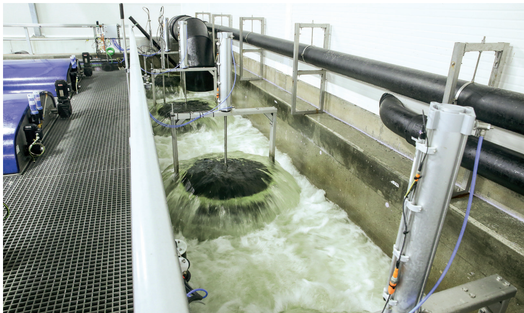
Avansert RAS-teknologi sørger for at avløpsvannet blir resirkulert. En forutsetning for at fisken skal leve er at oksygeninnholdet er nøyaktig. VAQ er totalleverandør av prosesseteknologien.
