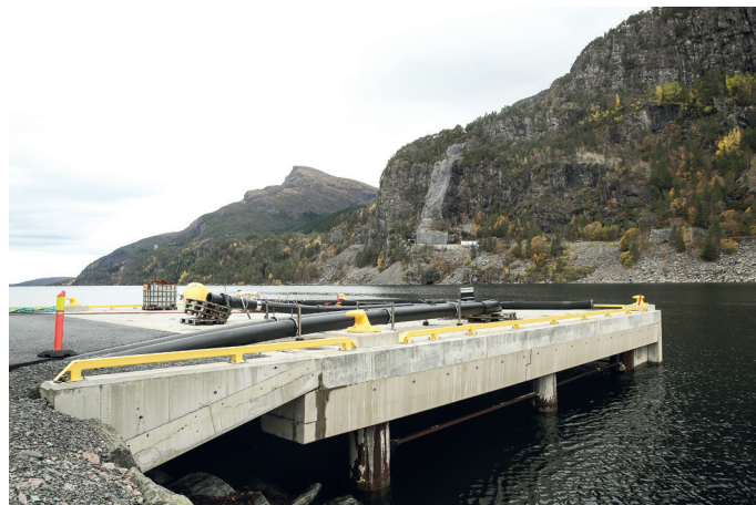
Kaia er 20 x 25 meter. Den er bygget med peler i sjøen og prefabrikerte betongelementer.
