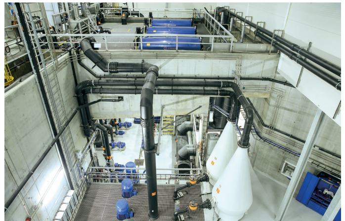
Denne delen av bygget kalles RAS-dekke. Som vi ser er det mange rør og instrumenter som skal på plass for å få anlegget til å fungere.
